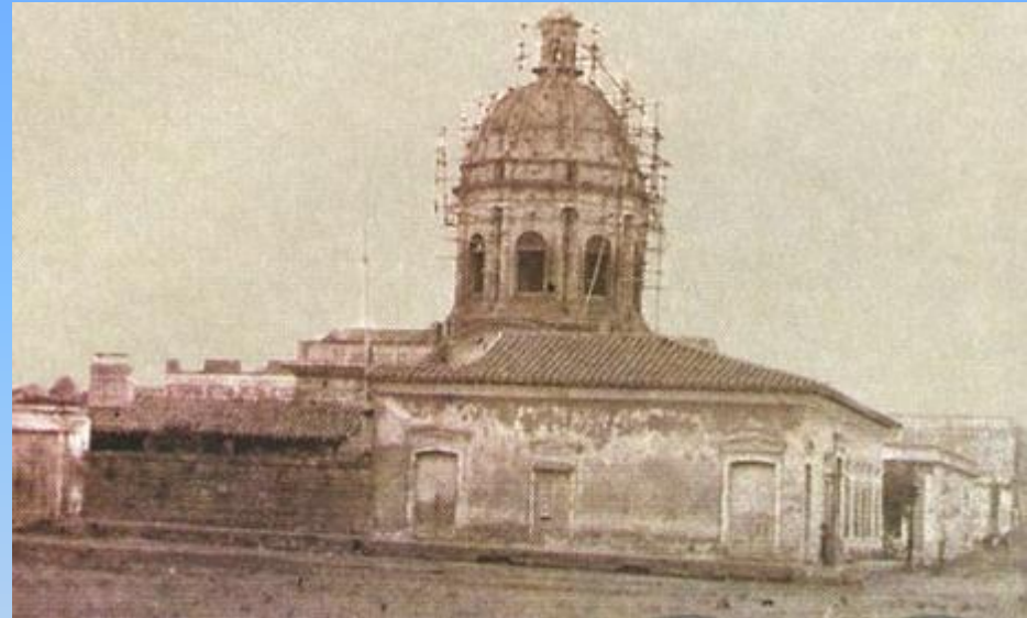
Oratorio en construcción
