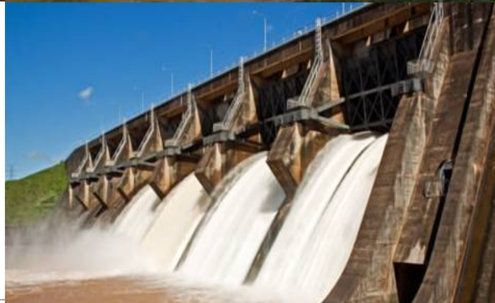
Central hidroeléctrica Acaray
